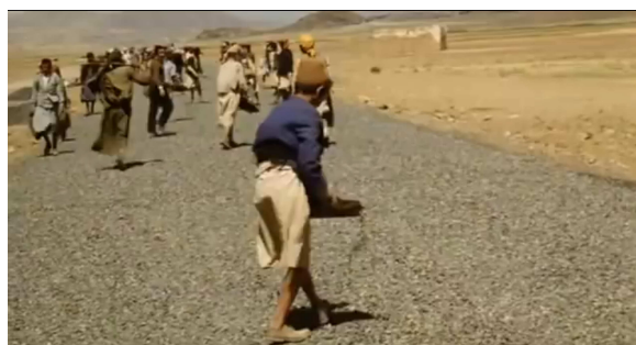
Figure 104 : Les enfants qui répartissent des cailloux sur la route en construction
