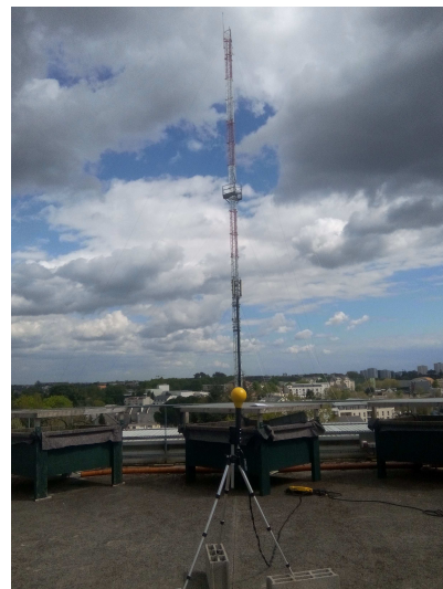
FIGURE 2.13 – Station SFR vue du point de mesure
