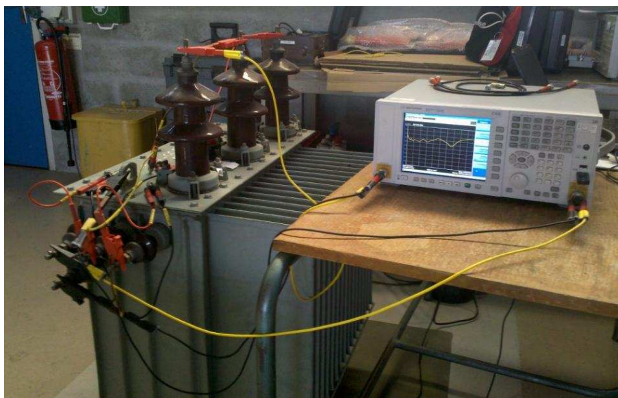
Figure 2.76 : Illustration du raccordement de l'analyseur de spectre au transformateur de distribution
