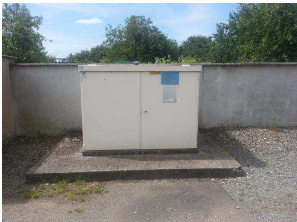
Figure 4.28 : Poste HTA/BT préfabriqué béton/métallique
